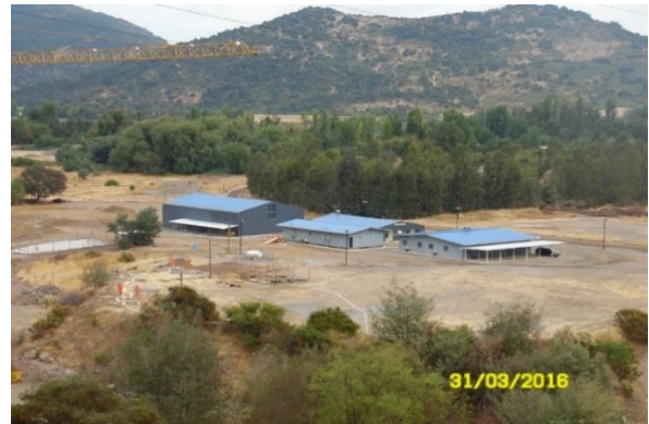
Vista panorámica desde el Muro lado Sur de la Instalación de Faenas. Se aprecia la Jaula de Sustancias Peligrosas lateral a la Bodega, instalación Balón de Gas Licuado, Patio de Desechos y Estacionamiento Techado terminado.
