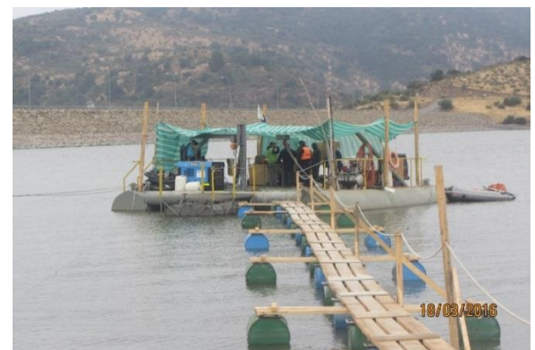
Detalle Pasarela Flotante. Se aprecia la Balsa de Traslado y el
