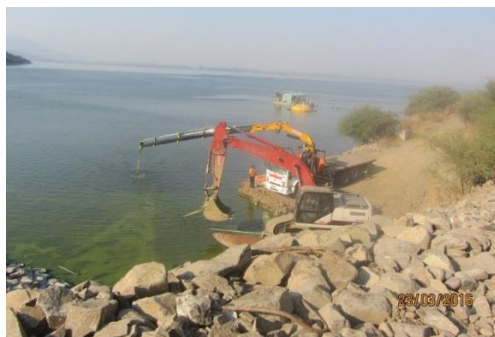
Instalación del Spool N° 1 con la ayuda de buzos y globos, la excavadora Link Belt y el Camión Pluma. Se aprecia la Balsa de Trabajo y el Tapón Toriesférico.
