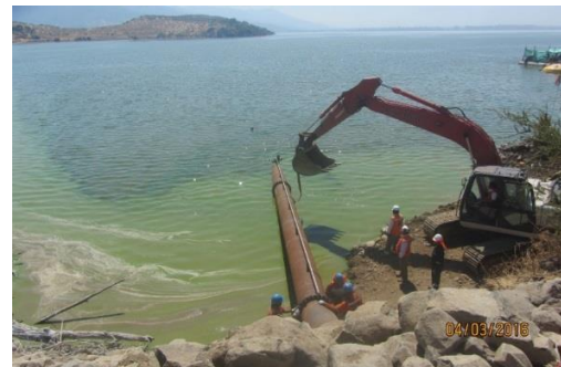
Posicionamiento de los Spool N° 2 y 3 con la excavadora Link Belt 210 y hundimiento mediante la apertura controlada de la válvula del Flange Ciego y posterior retiro del Flange Ciego por el Buzo.
