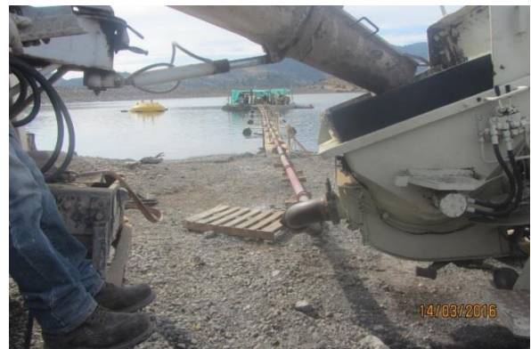
Faena de Hormigonado. Se aprecia la Cañería para hormigonar bajo el agua, a través de la playa y la Pasarela Flotante.
